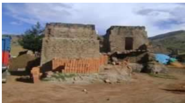
Figura 5.51. Hornos artesanales para elaboración de ladrillos
