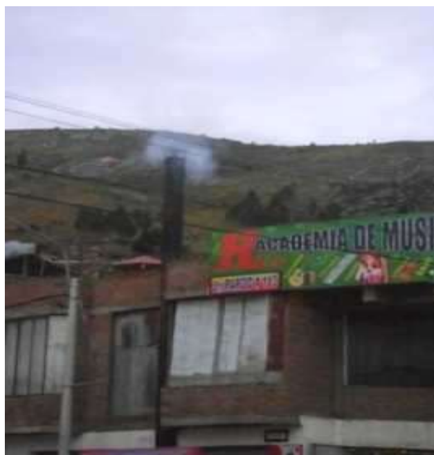
Figura 5.53. Chimenea de Pollería (Av. La Torre)
